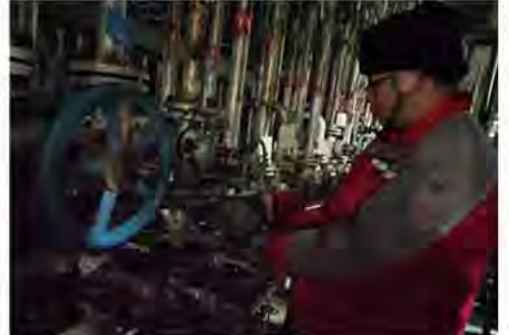
（图为生产运行中心丁班外操正在管排切水防冻）
